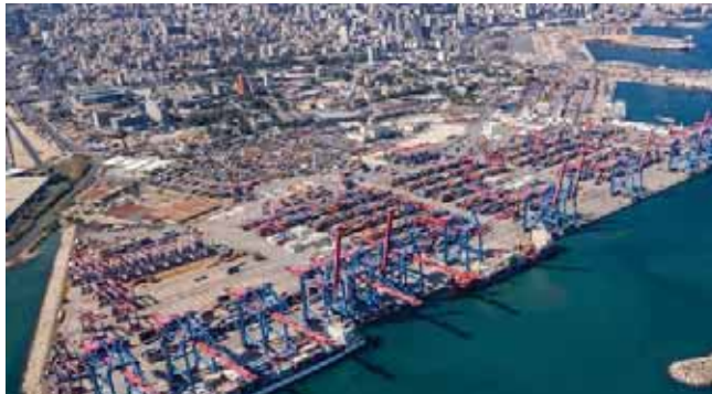
محطة الحاويات في مرفأ بيروت
