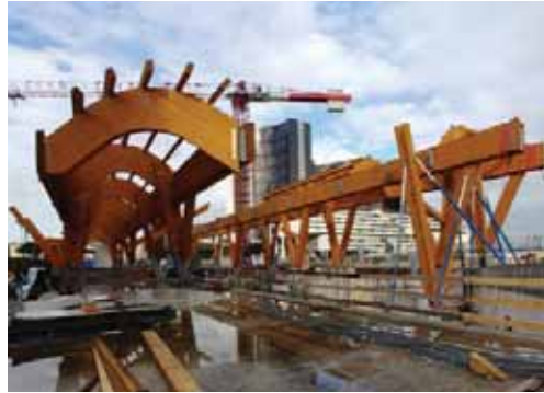
مترو ستيشن - زرقية (محطة وجسر تحت الإنشاء)
